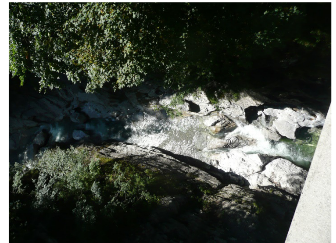
Brücke über die Dürrachklamm
